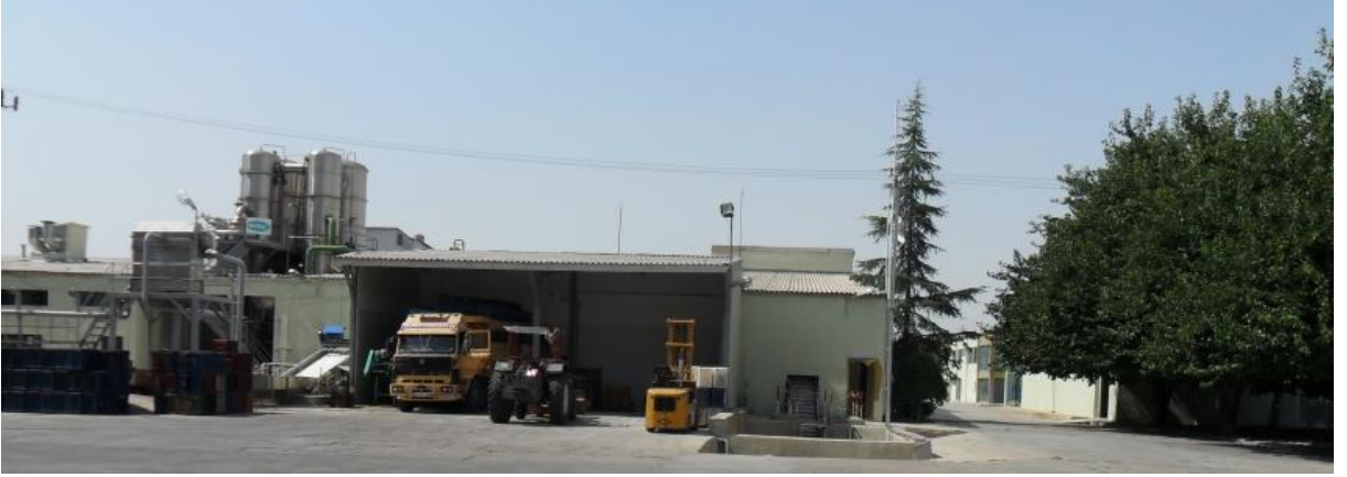
Ersu Fabrikası - Üretim Tesisinin Meyve Meyve Giriş Kısmı
